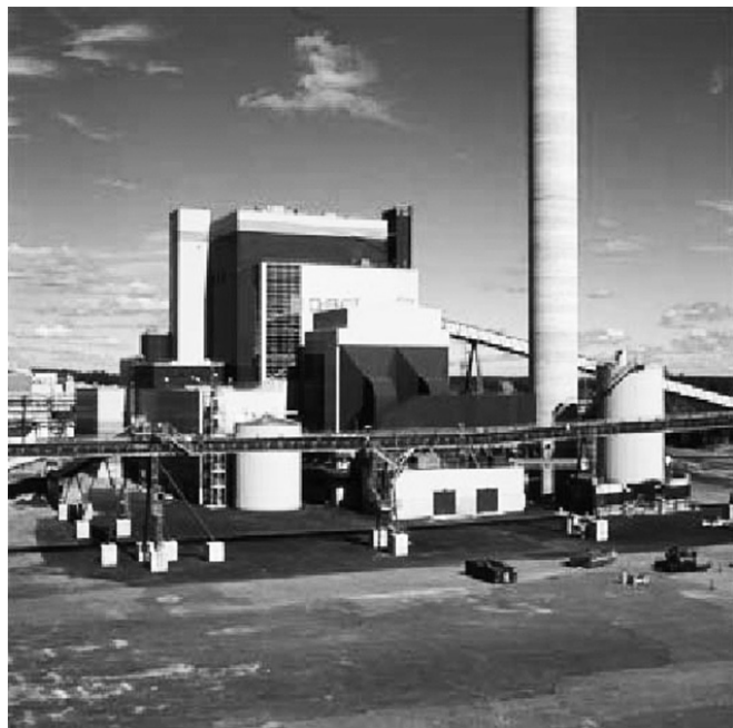
Рис. 3. Установка с барботированным псевдосжиженным слоем (компания Kumin Voima Oy)
