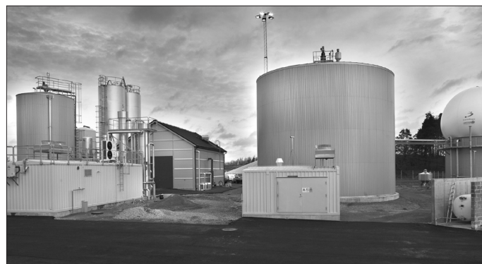
Рис. 2. Вид завода по производству биогаза
